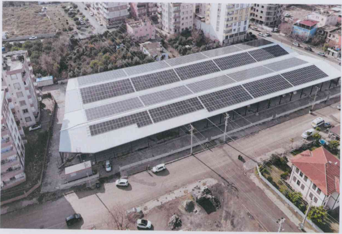
700 Kw Güneş Enerji Sistemi (GES) Yapım İşi:
