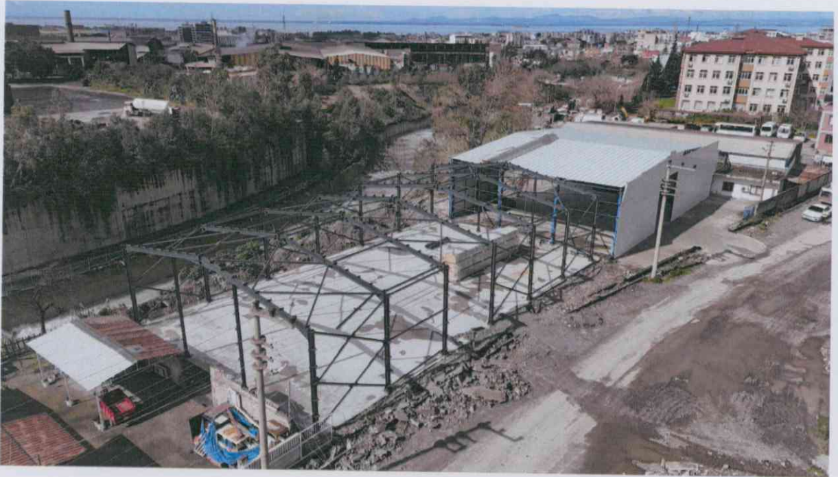
Depo Yapım İşi:
