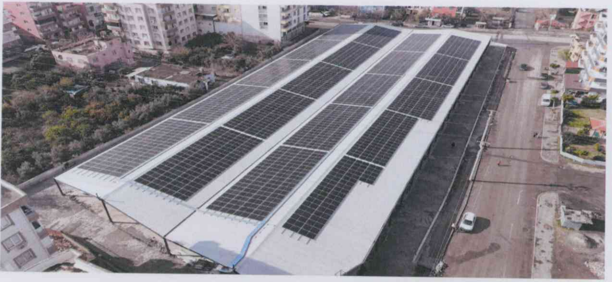
Kapalı Pazaryeri Yapım İşi:
