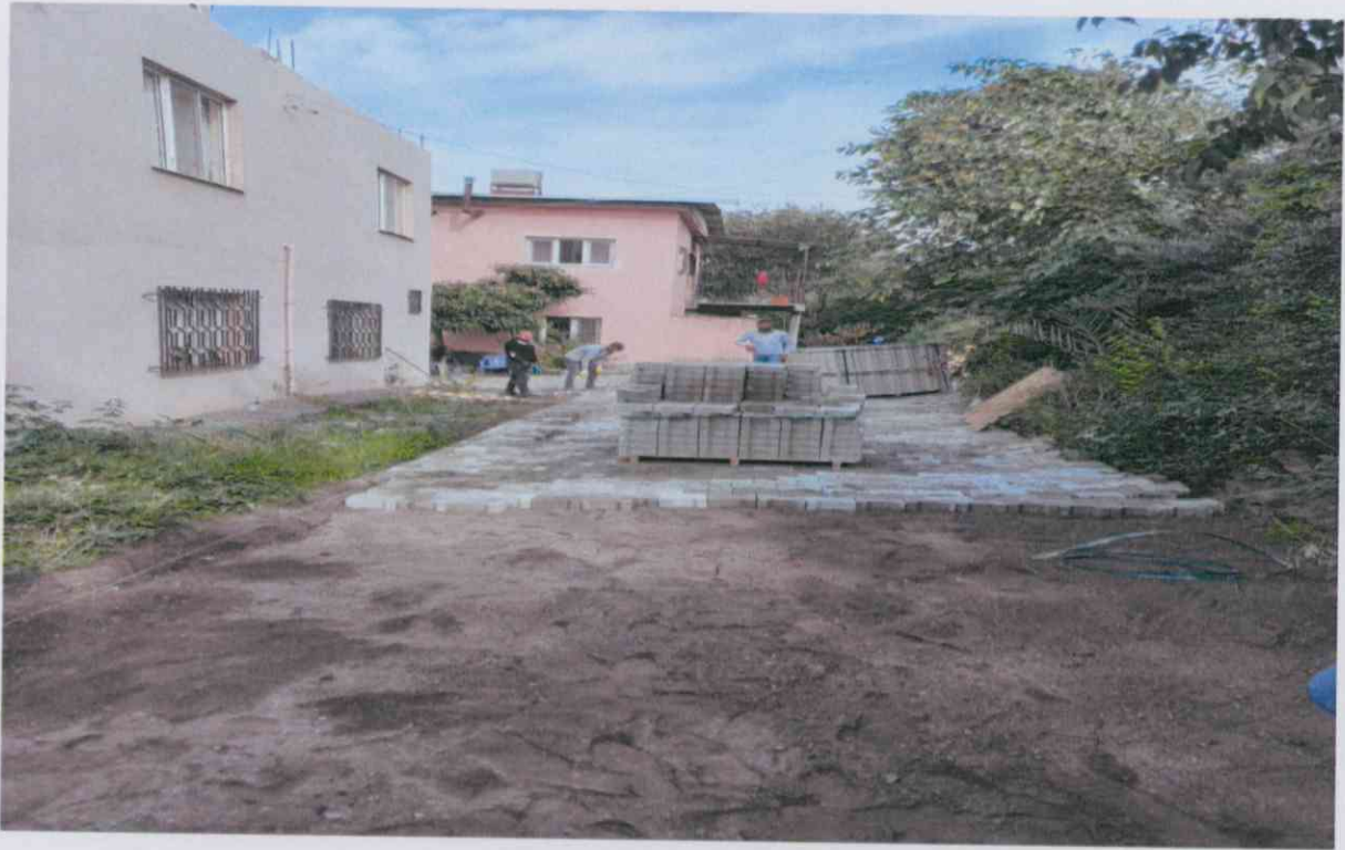
Parke Yol ve Tamirat Yapım İşi 2.Etap:
